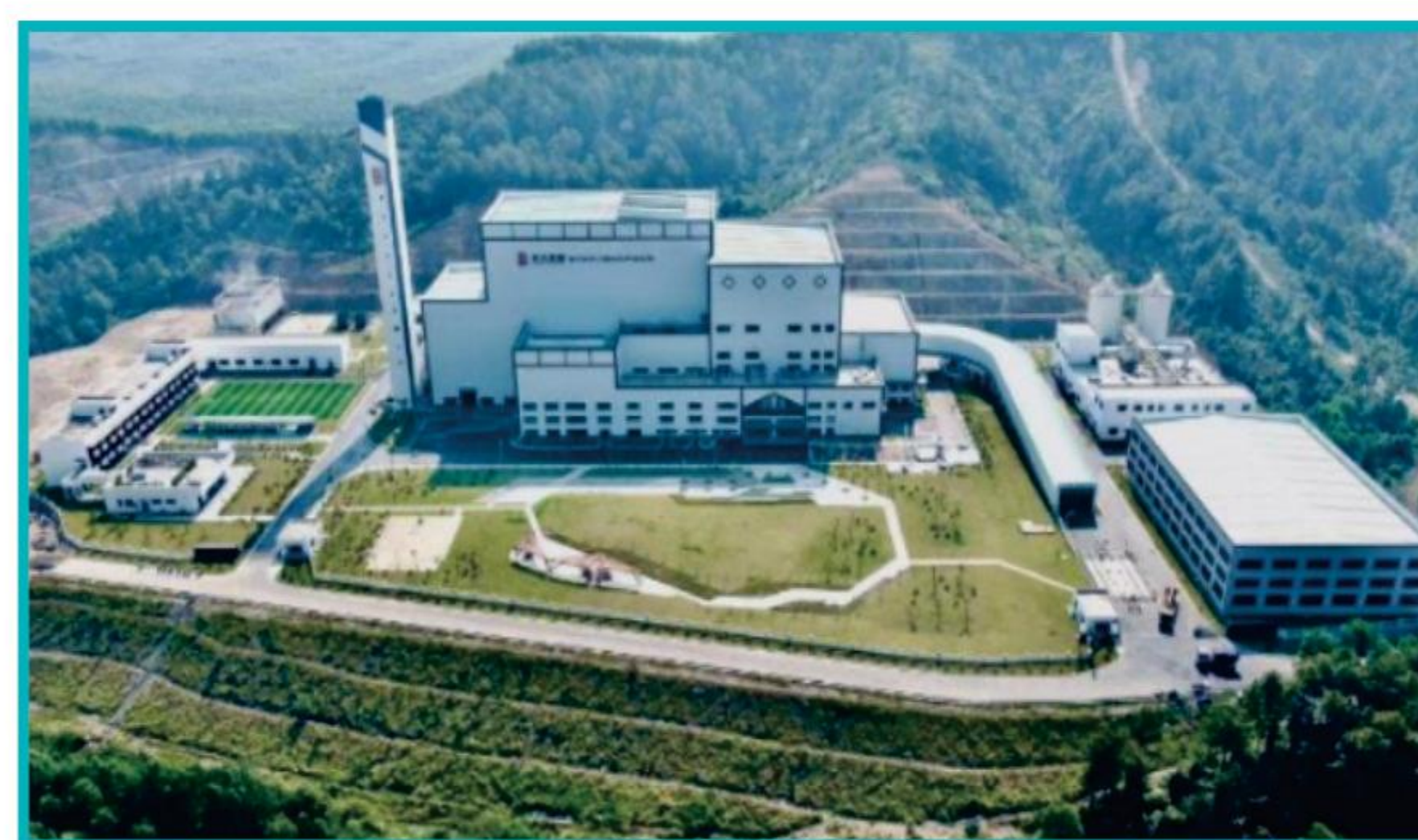
► 500tpd 越南顺化垃圾焚烧项目 ► 光大供货炉排炉+烟气系统+渗滤液系统
