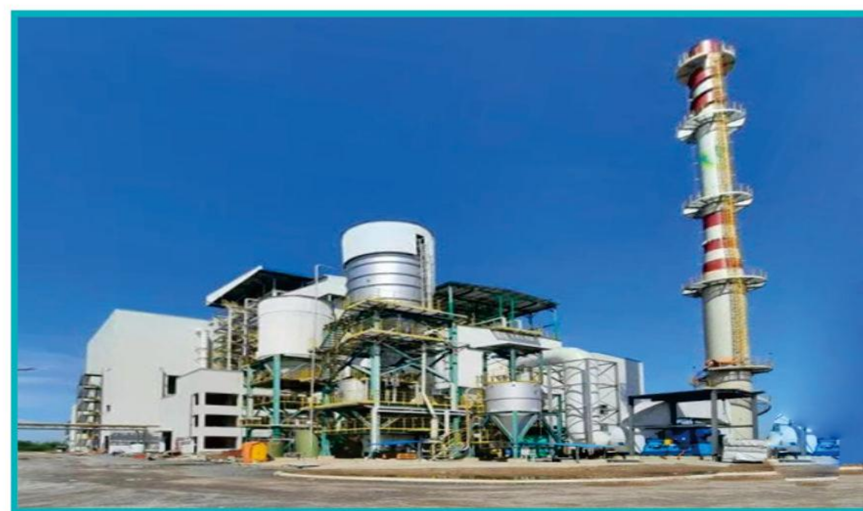
► 350tpd 越南后江垃圾焚烧项目 ► 光大供货炉排炉+渗滤液系统
