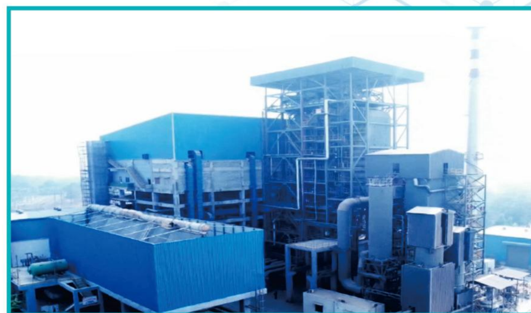
► 350tpd 印度雷瓦垃圾焚烧项目 ► 光大供货炉排炉
