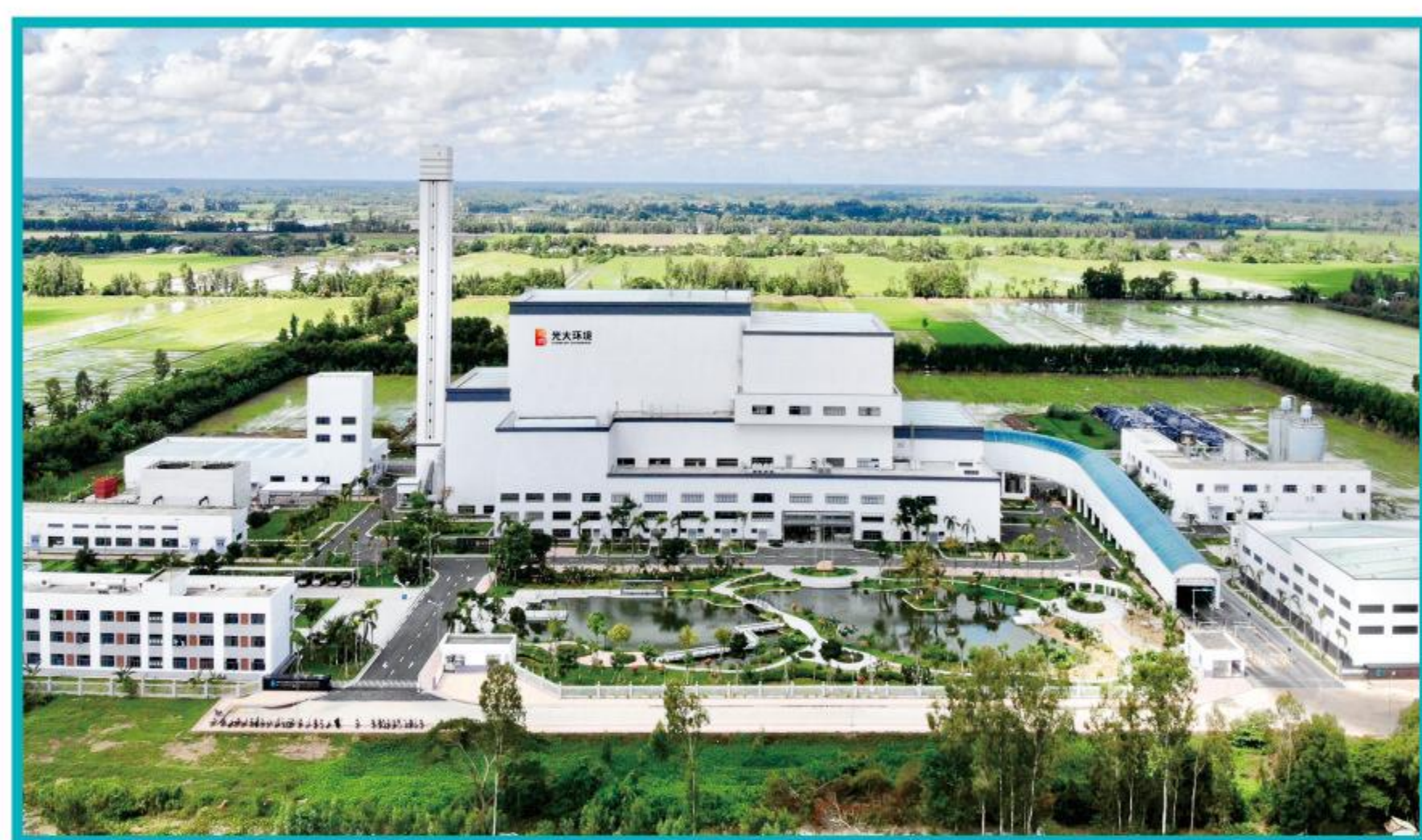
► 400tpd 越南芹苴垃圾焚烧项目 ► 光大供货炉排炉+烟气系统+渗滤液系统
